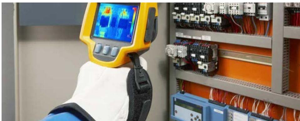
Figura 2 - Análise termográfica de acionamentos elétricos
